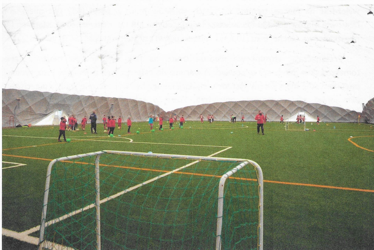
Hala pneumatyczna w Stalowej Woli
